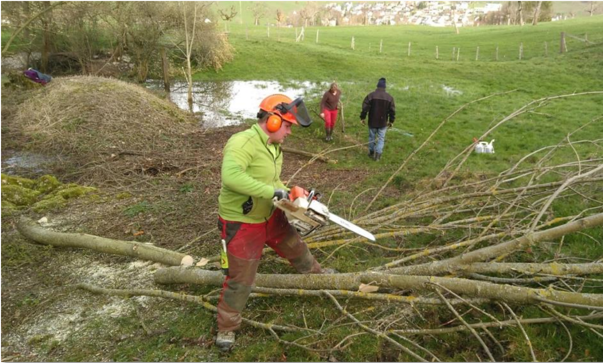
Rodungsarbeiten im März ...
