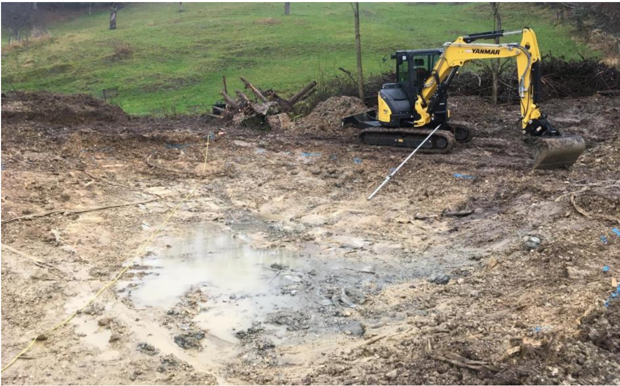
Aushub des Weihersubstrates bis auf das alte Vlies im Dezember 2020.
