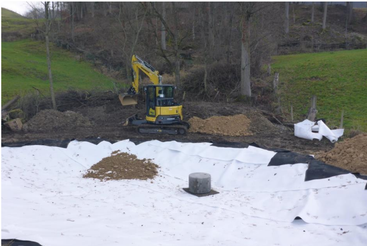
Das Schutzvlies wird auf die Kautschukfolie verlegt.
