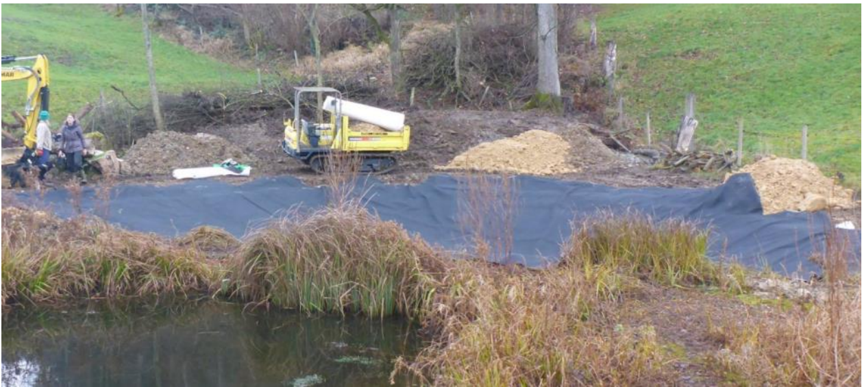
Einbau der Kautschukfolie
