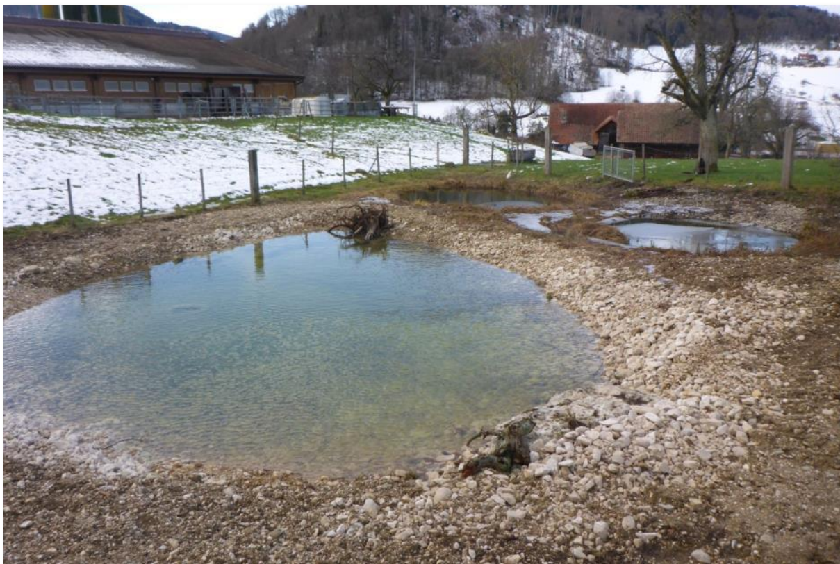
Der fertig sanierte und wieder aufgefüllte Weiher.
