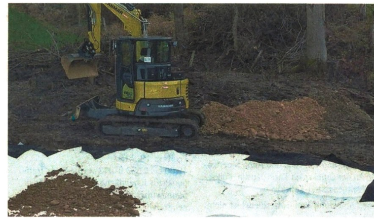
Einbau eines Schutzvlieses.
